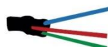
Fig. 1.4 Con los pasos anteriores se generó un sello que evitará el paso de humedad.
